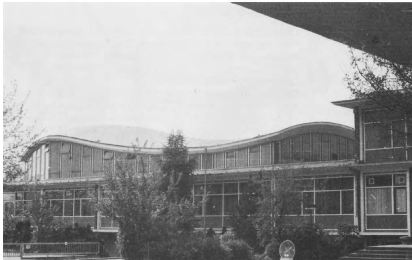
Aula des Hans Ehrenberg-Gymnasiums Raumabschluss des Ehrenbergplatzes und nördliche Begrenzung der Maiwiese
