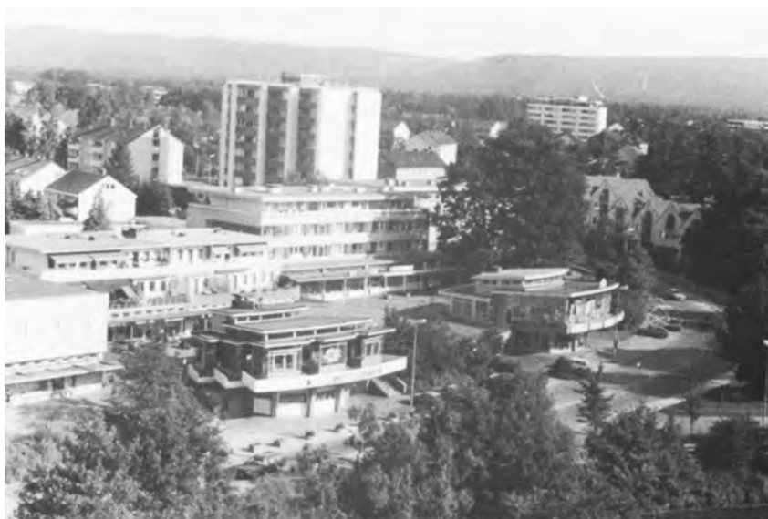
Sennestadtring/Vennhofallee Ladengruppe West
