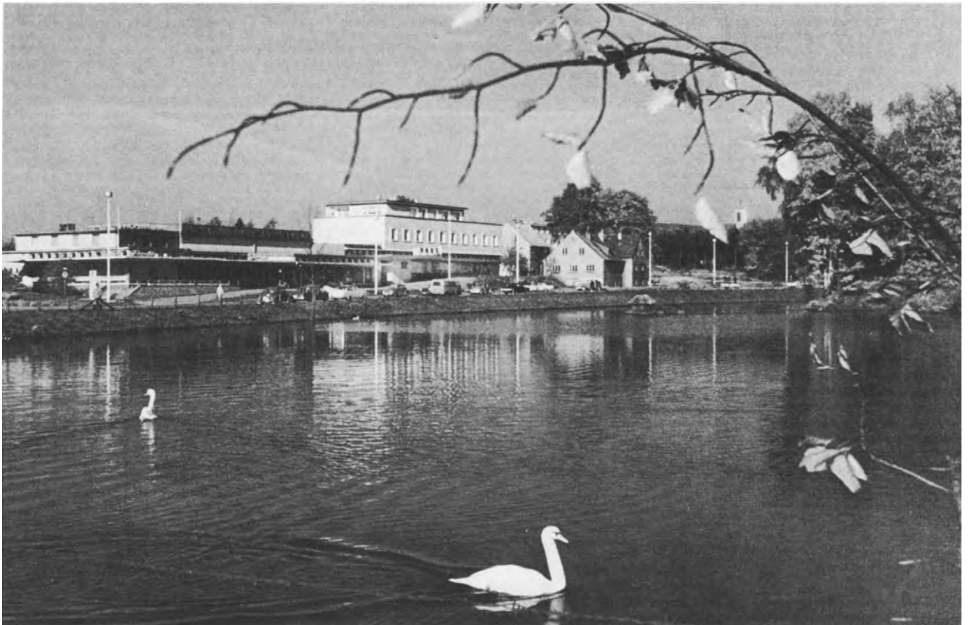
⑤ Derselbe Blick über den inzwischen innerhalb der Ringstraße aufgestauten Stadtweiher, rechts hinten die alte Mühle kurz vor ihrem Abbruch
