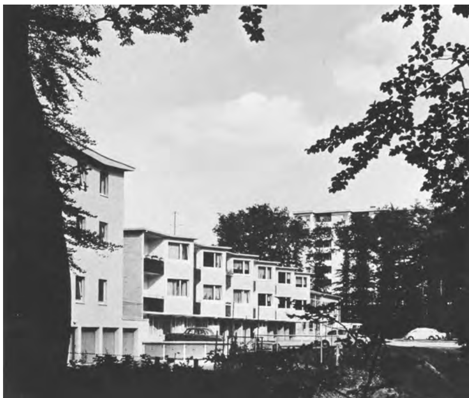
②③ Rückfront der südlichen Ladenzeile an der Westallee (Architekten Reichow, Hüttemann und Rösler)
