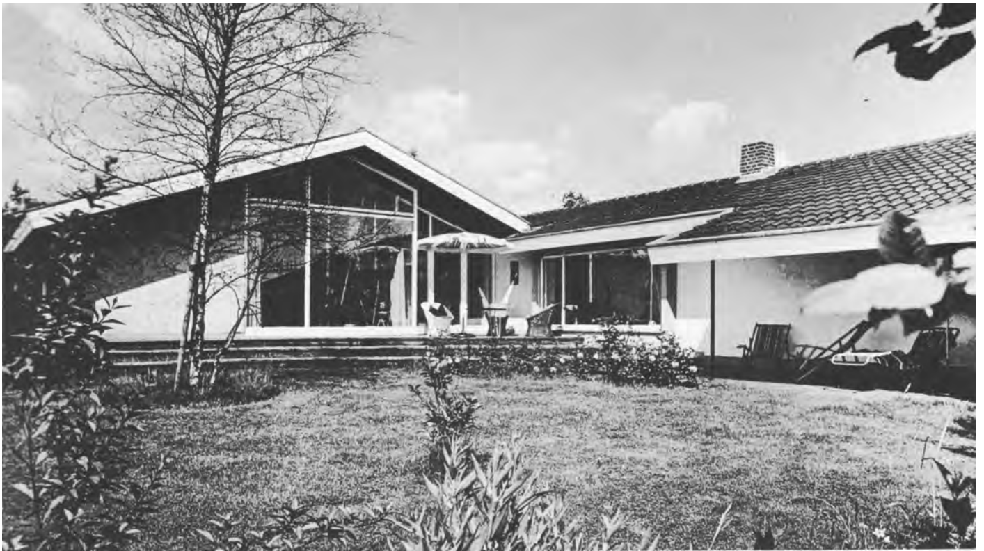
②⑨ Oben: Einfamilienhaus P. am Ost-West-Grünzug (Architekten Reichow und Eggeling, Mitarbeiter Quilling)
